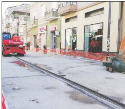
Lavori in atto su corso Umberto a Soverato
