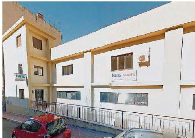
Centro Baden Powell In corso i lavori per le barriere architettoniche
